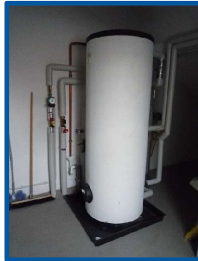
Warmwasserspeicher
