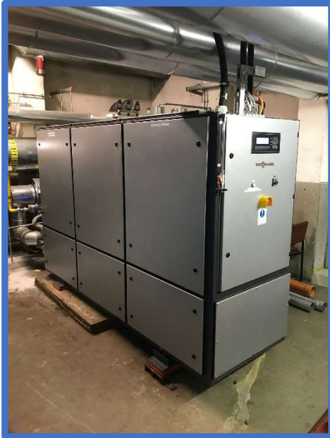
BHKW und Heizkessel in Haus E
