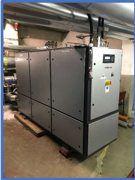
BHKW und Heizkessel in Haus E
